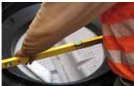
Kontroll av installation
