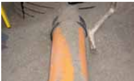
Komprimering med handkraft
