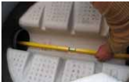
Kontroll av fall
