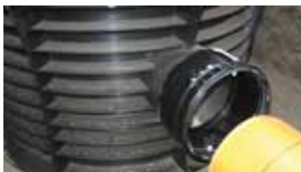
Montering av rör
